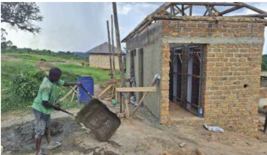
Koulun WC-rakennus työn alla
