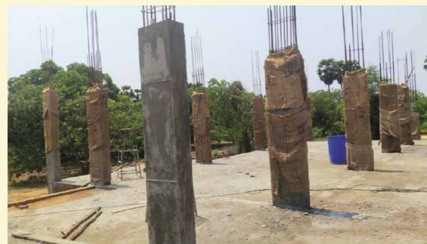
NHH-poikienkodin tämän hetken rakennusvaihe
