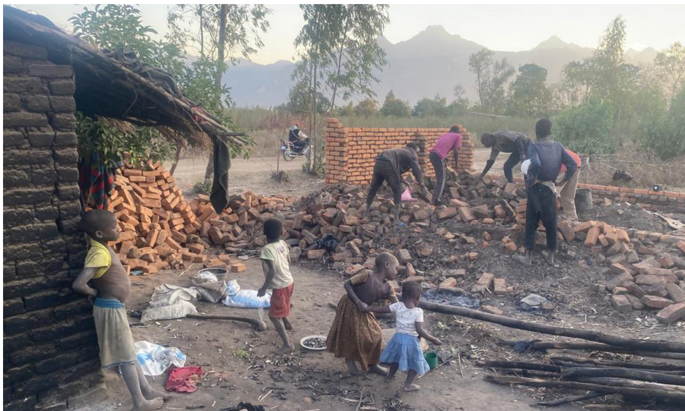
Kostunutta taloa puretaan.
