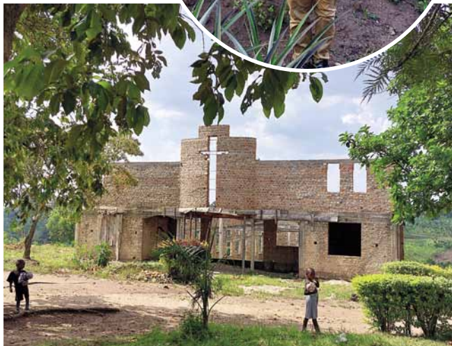
Muleeten rakenteilla oleva kirkkorakennus.
